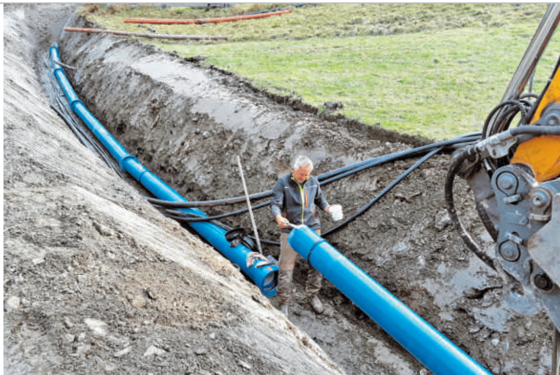
Die Arbeiten haben mit der Erneuerung der Wasserleitung schon begonnen.
