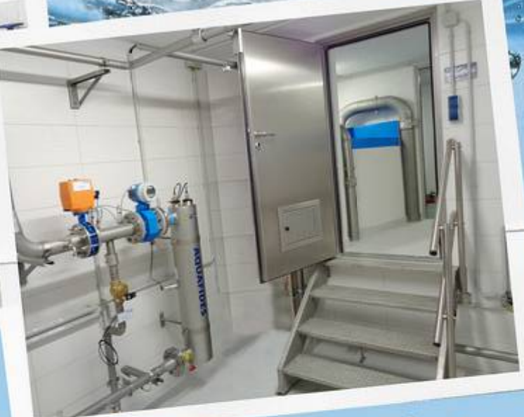
UV-Desinfektionsanlage
